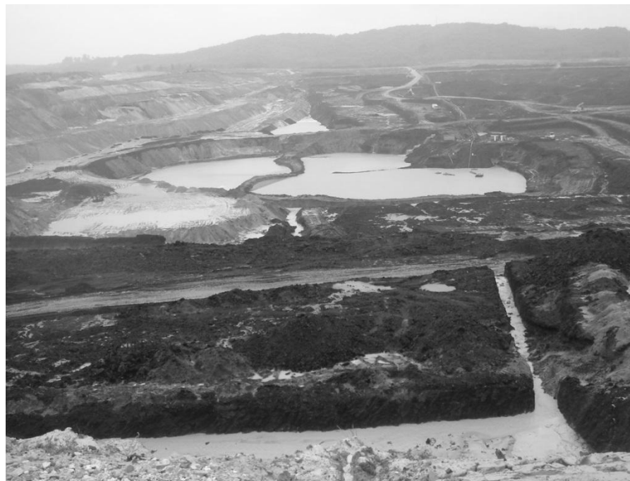
Slika br.4. Glavni vodosabirnik i taložnici na kopu 15.05.2014. ( \Sigma_{dn.p.}=95 \text{ l/m}^2 )
