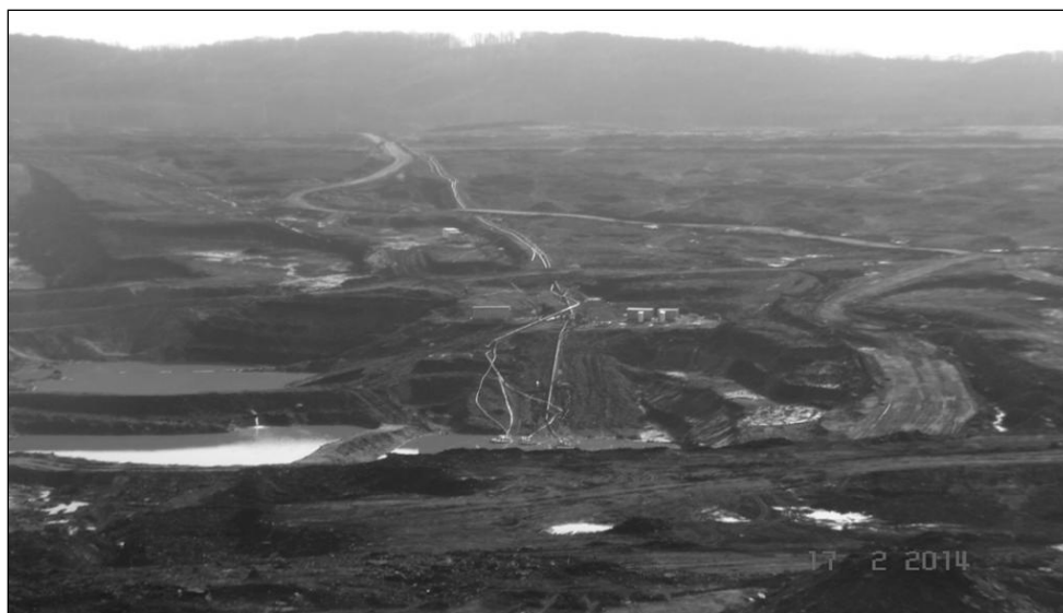
Slika br.2. Glavni vodosabirnik i taložnici na kopu
