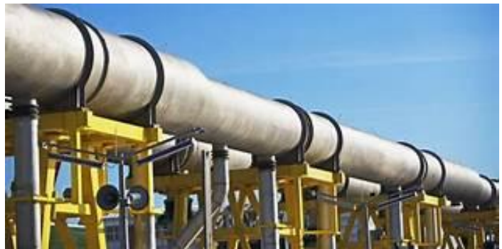
Слика 12.16. Лаке и тешке носиве конструкције цјевовода
