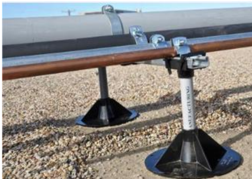
Слика 12.16. Лаке и тешке носиве конструкције цјевовода
