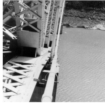
Вођење цјевовода по мостној конструкцији
